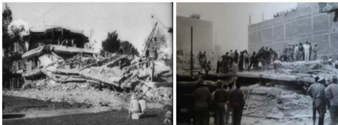
Figura 21 colapsos totales causados por el sismo de 1957
