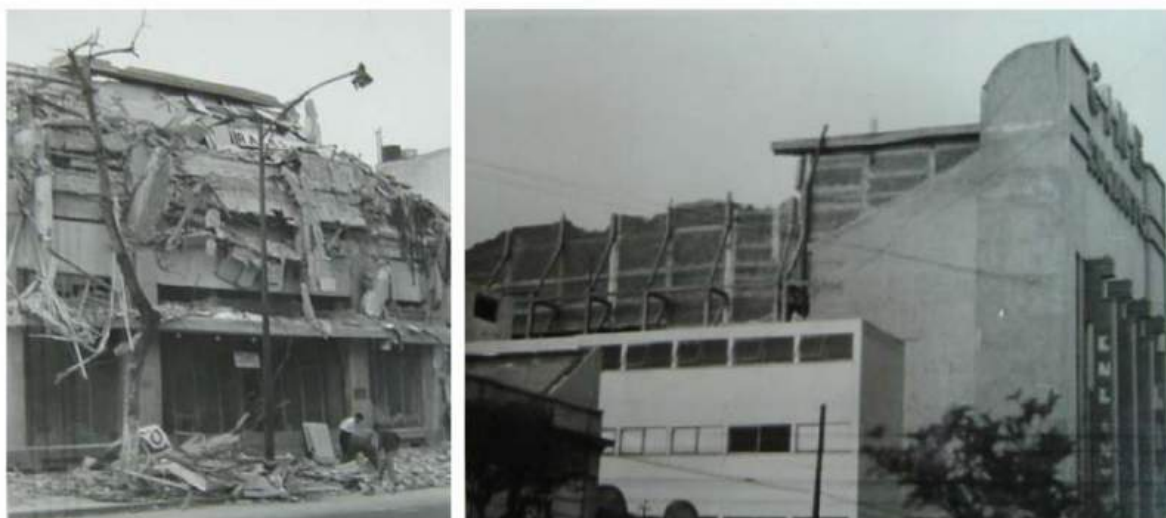
Figura 6. Colapsos parciales: a) edificio en Insurgentes # 377, sólo la planta baja quedó en pie y b) Cine Encanto que perdió el techo y parte de los muros.
